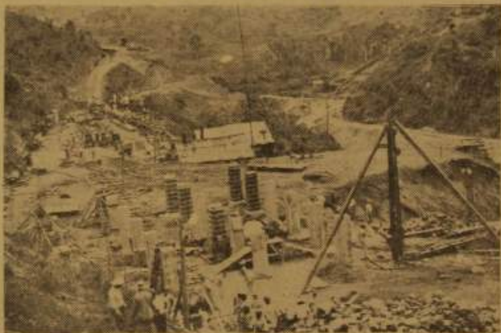
Parorama das obras que estão sendo executadas em Macabú
